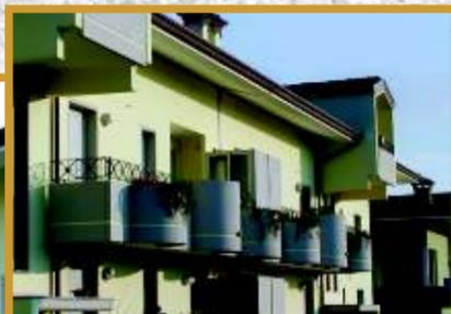
Parapetti prefabbricati con diverse tipologie, sezioni e finiture, molto indicati per l'ottima estetica e facilità di montaggio, in quanto gli ancoraggi sono studiati per qualsiasi tipo di soletta e risultano economici rispetto ai parapetti eseguiti in opera.
